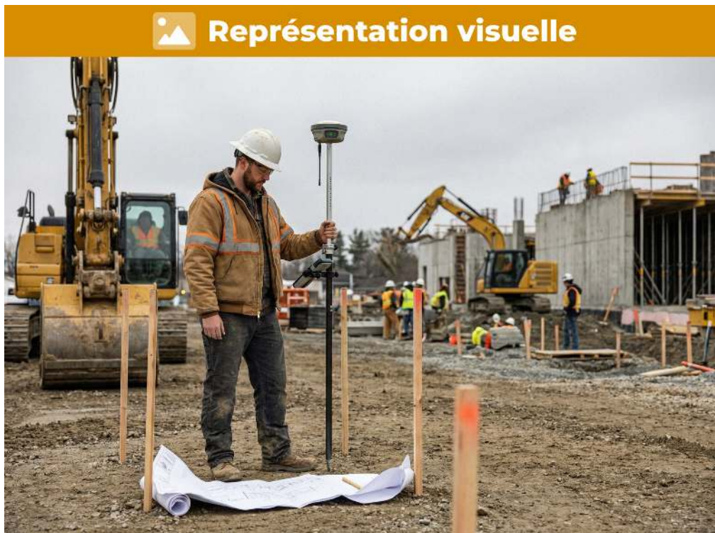
GNSS en RTK: précision horizontale de 2 cm, verticale de 5 cm pour relevés rapides
