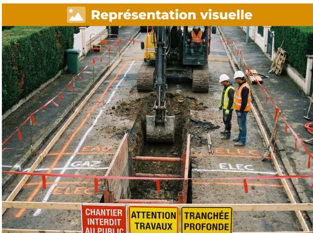
Ouverture d'une tranchée de 12 m pour pose de bordures, sécurité essentielle
